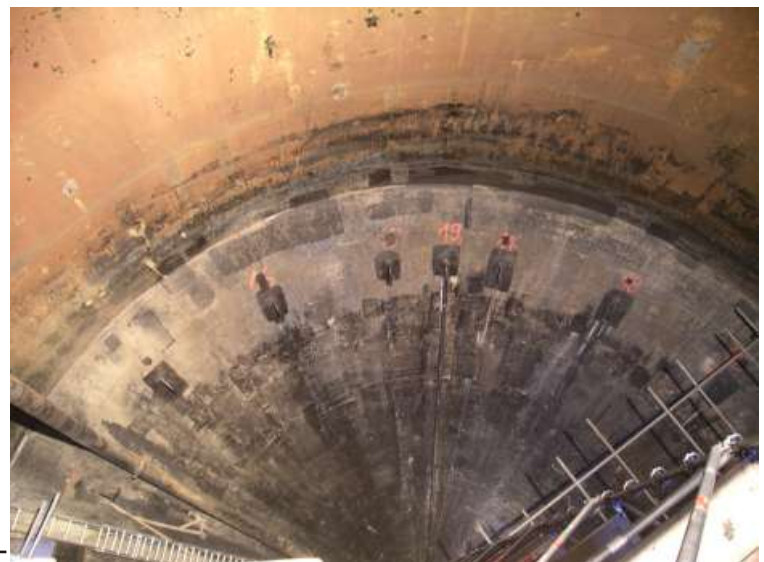
Trichterboden des Faulraumes
